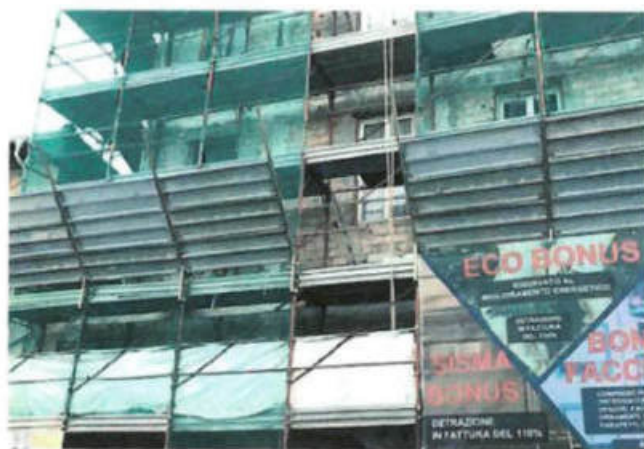
Uno dei cantieri per la ristrutturazione dei palazzi a Imperia
