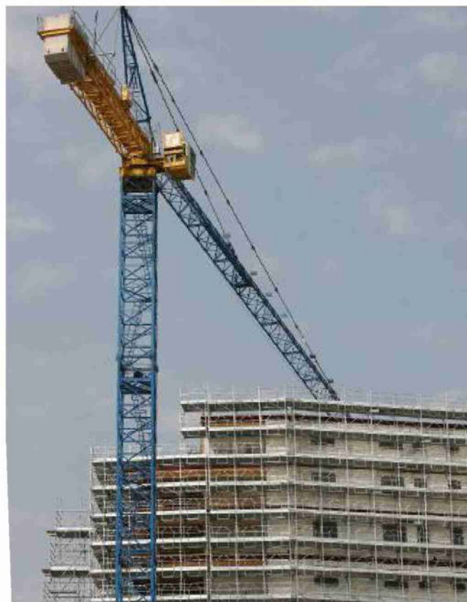
Un cantiere edile Salta la sospensione prevista per far fronte ai rincari
