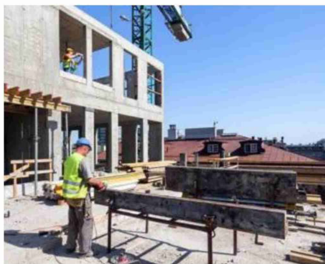
Operai al lavoro
