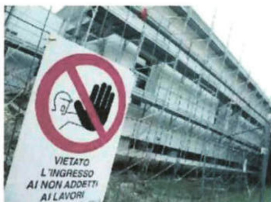
IN DIFFICOLTA' Le ditte edili lanciano l'allarme: stop ai cantieri
