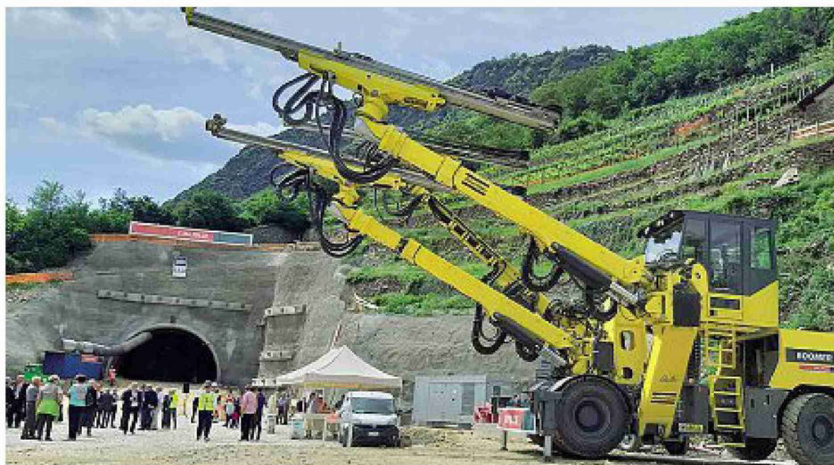
Difficoltà Il cantiere della circonvallazione a Castelbello in Venosta
