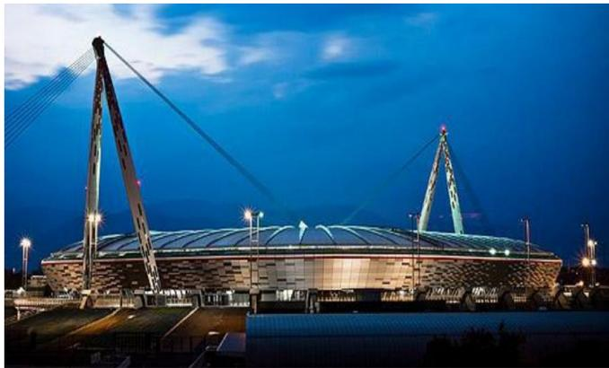
**JUVENTUS STADIUM (Torino):** Recupero dei materiali dismessi del vecchio Stadio “Delle Alpi”. 40.000 metri cubi di calcestruzzo, per sottofondo del rilevato strutturale del nuovo impianto
