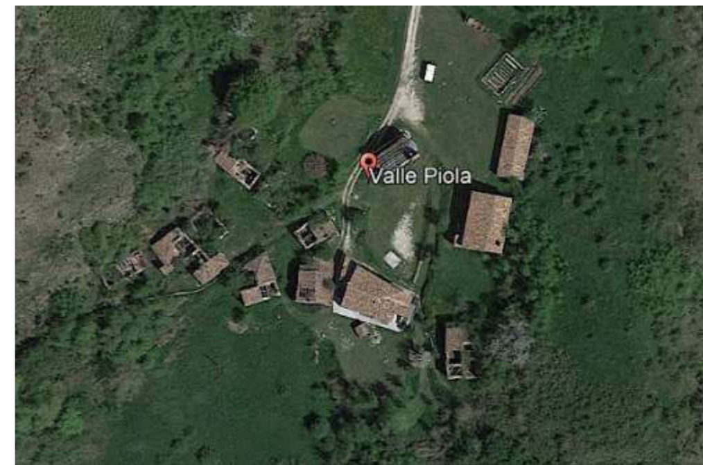
VISTA DALL'ALTO DELL'AREA
