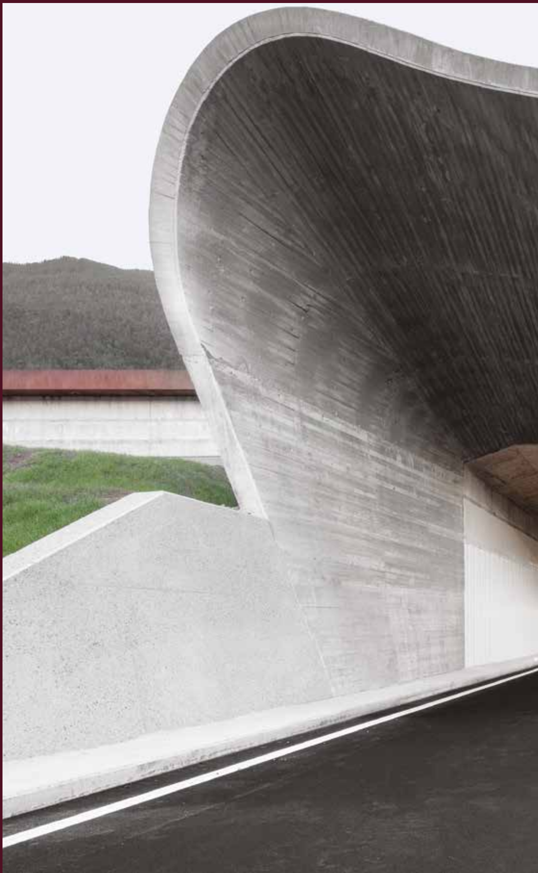
Nuovo portale di ingresso della Circonvallazione Bressanone-Varna, 2020, MoDus Architects (Foto Gustav Willeit)
