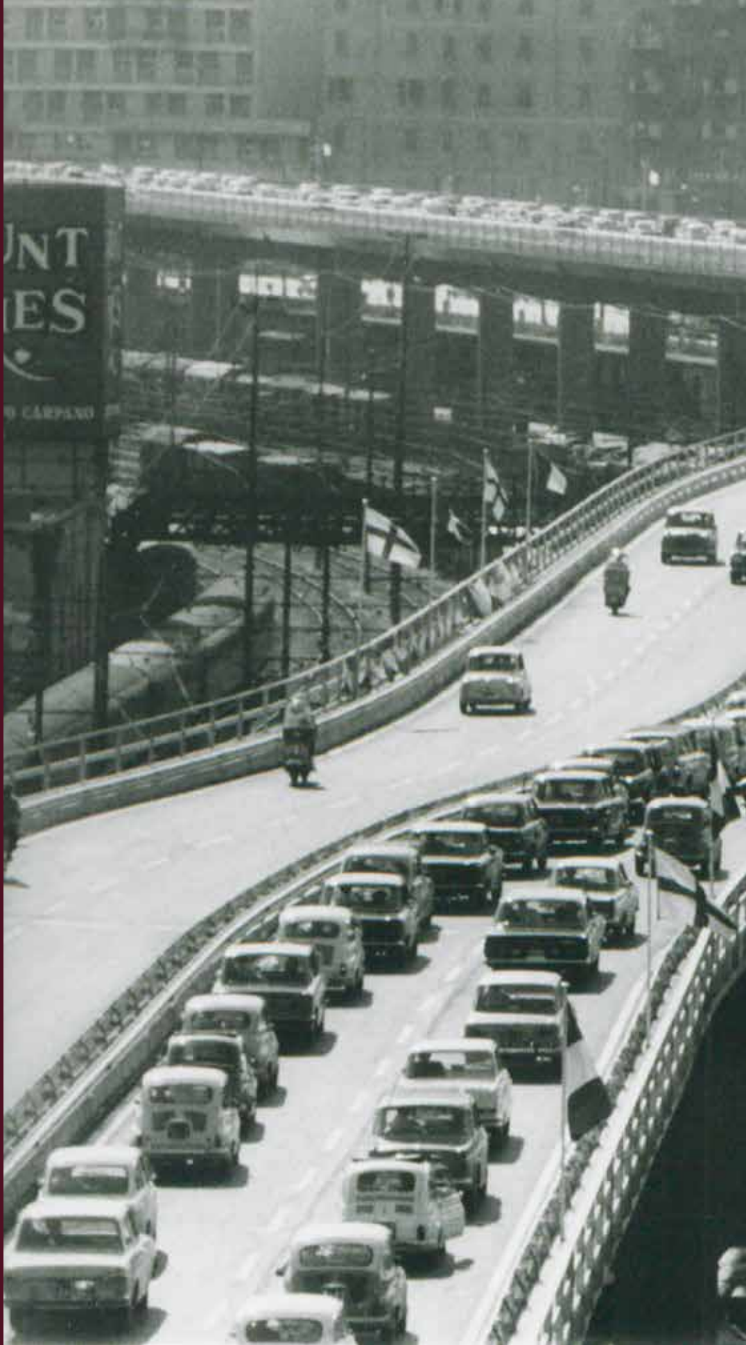
Archivio fotografico Fintecna - Gruppo CDP Sopraelevata
