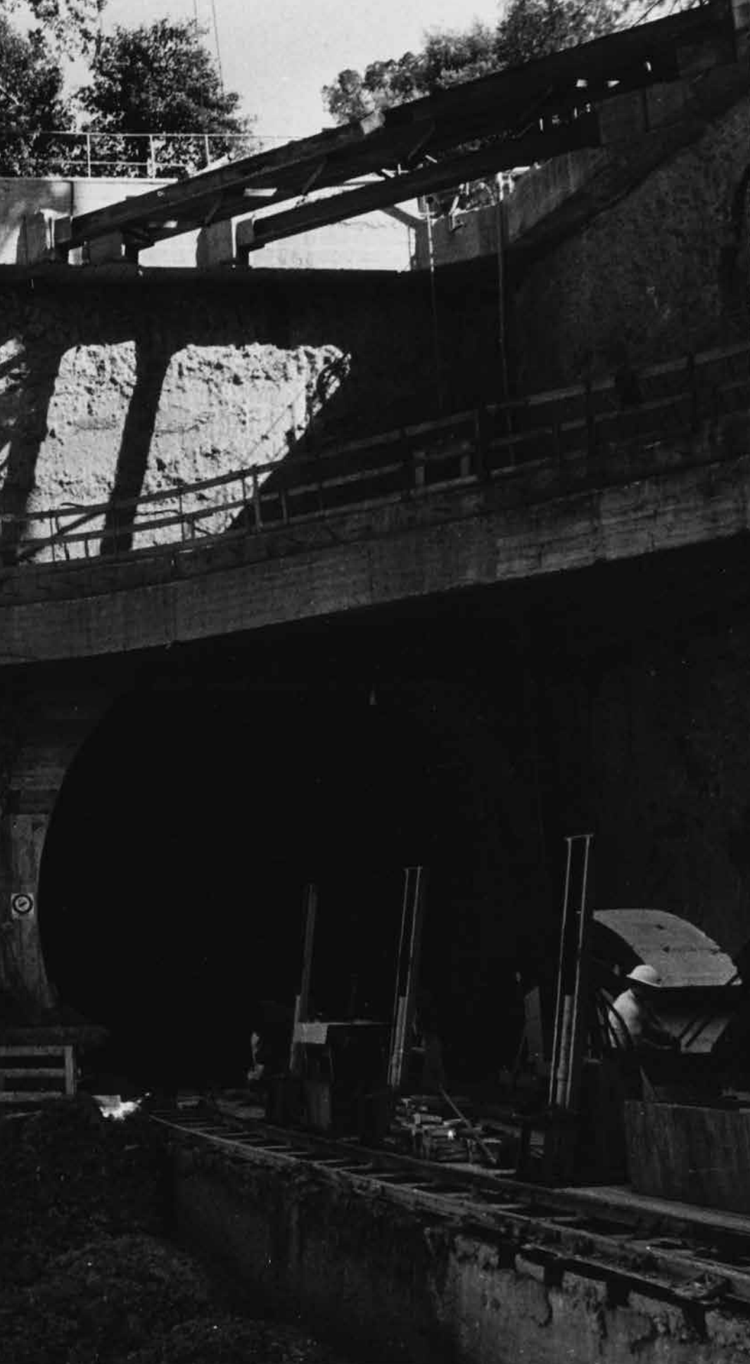
Archivio fotografico Fintecna - Gruppo CDP Roma - Lavori di costruzione della metro A - Operai
