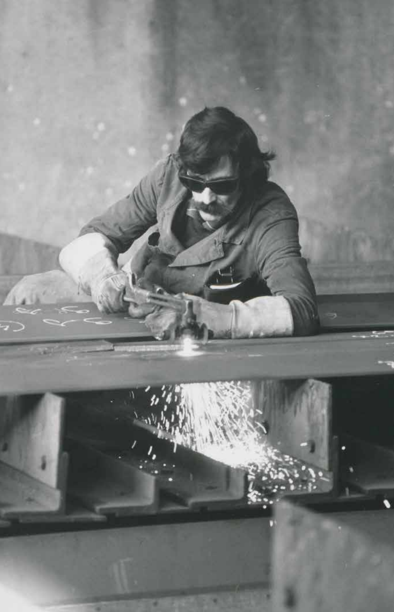
Immagine di Enzo Ragazzini - Archivio fotografico Fintecna - Gruppo CDP Operaio in cantiere
