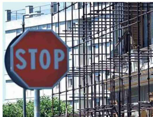
Un cantiere edile fermo dopo lo stop al Superbonus del 110% ANSA/ROBERTO RUSCELLO
