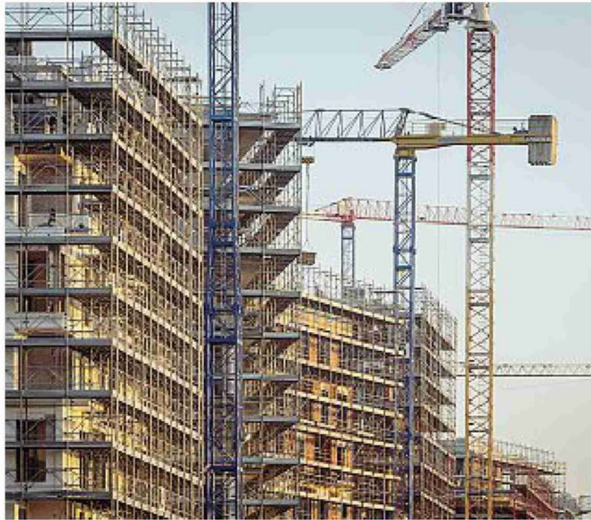
Trasformazioni Il cantiere del progetto Seimilano di Borio e Vårde nell'area ex Calchi Taeggi a Bisceglie
