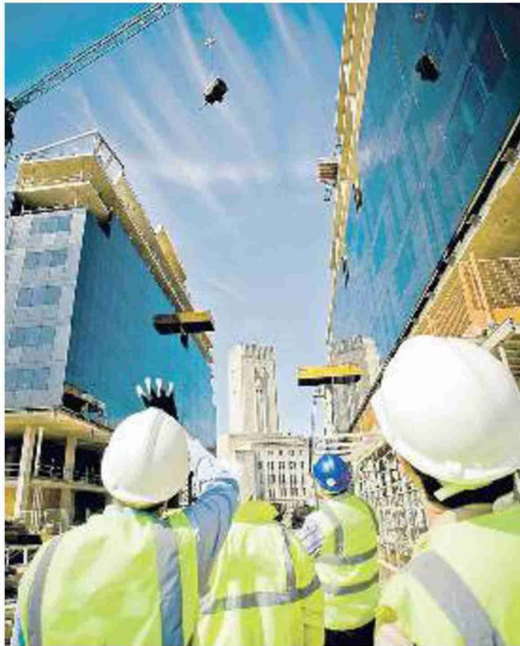
Un cantiere edile: il Pnrr assegna 55,7 miliardi già territorializzati
