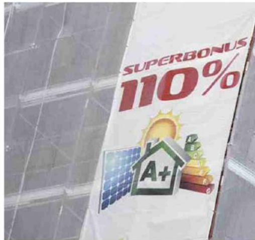
■ Un palazzo in ristrutturazione con il Superbonus
