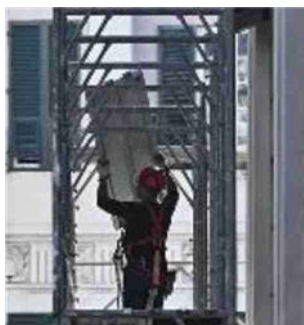
Lavori di edilizia
