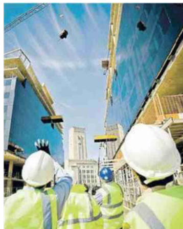
Lavori in corso in un cantiere
