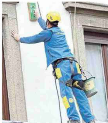
Un operaio in un cantiere
