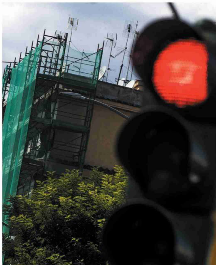
Un'impalcatura per i lavori di ristrutturazione di un condominio
