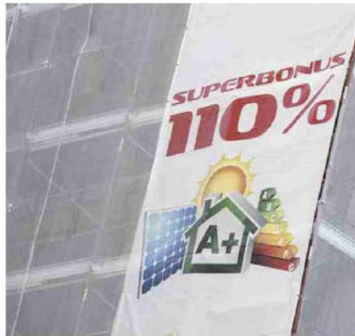
■ Un palazzo in ristrutturazione con il Superbonus
