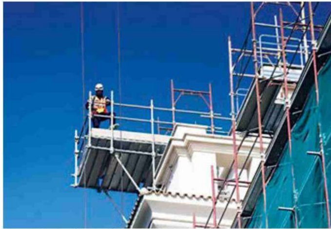
Un cantiere edile per il bonus 100 foto LaPresse
