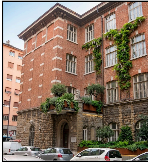
Vista facciata lato via Combi
