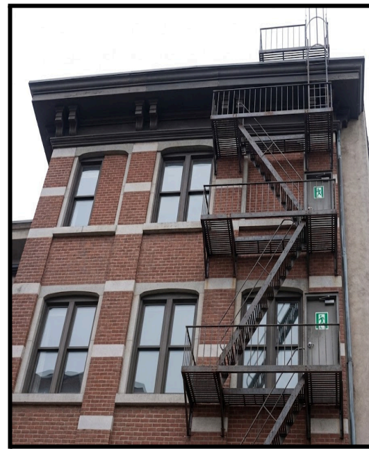
Installazione scala antincendio
