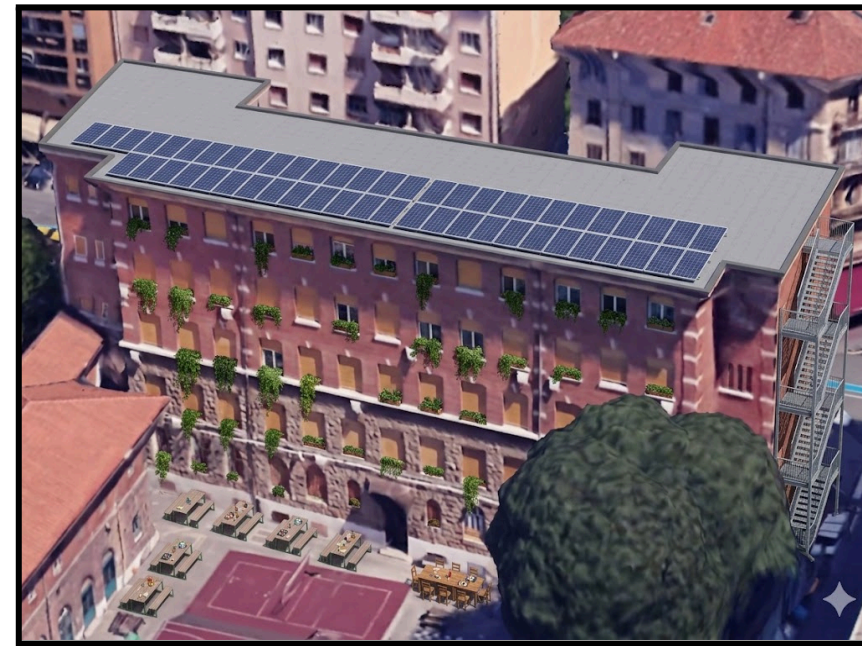
Visuale dall'alto dell'edificio con le modifiche esterne
