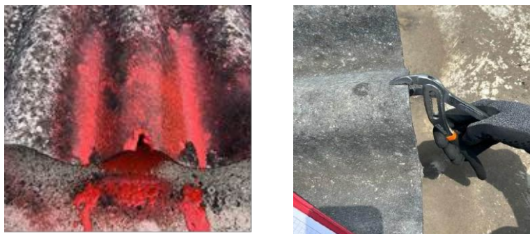
Figure 41 - prelievo del campione (dx) e sigillatura dell'area interessata (sx)
