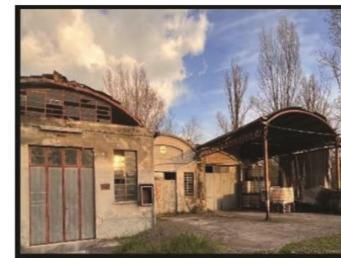
Fabbricati dismessi sul lato est dell'area
