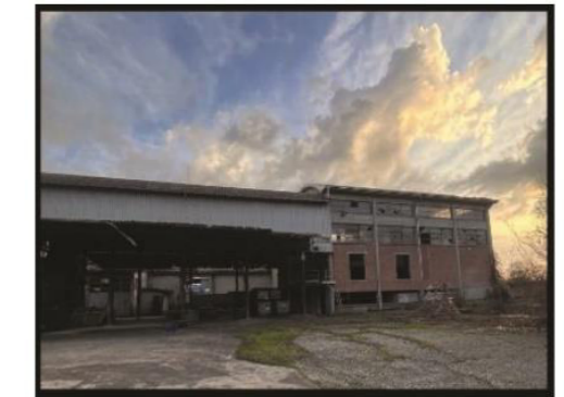
Esterno del fabbricato più grande sul lato sud dell'area.
