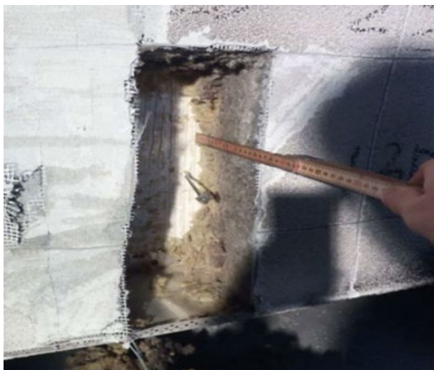
TEST - SISTEMI ETICS CON ISOLANTI INCOMBUSTIBILI
