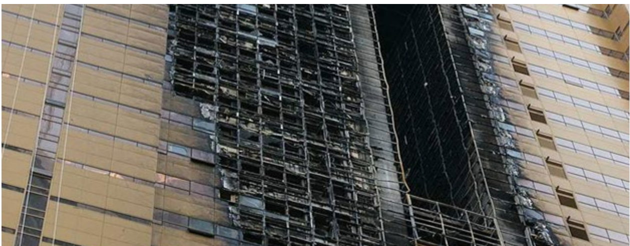
DIFFUSIONE DELL'INCENDIO ALL'INTERNO DI CAVITÀ VERTICALE INTERNA
