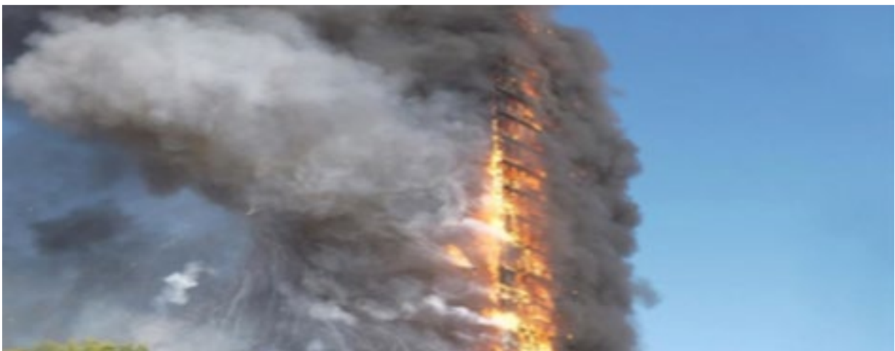
DIFFUSIONE DELL'INCENDIO SULLA SUPERFICIE ESTERNA DELLA PARETE
