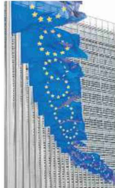
La sede della Commissione Ue
