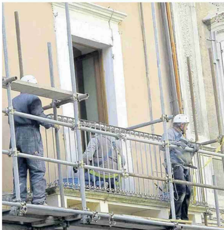
I lavori di ristrutturazione di un edificio
