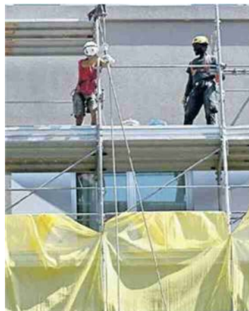
Un cantiere per la ristrutturazione di un condominio
