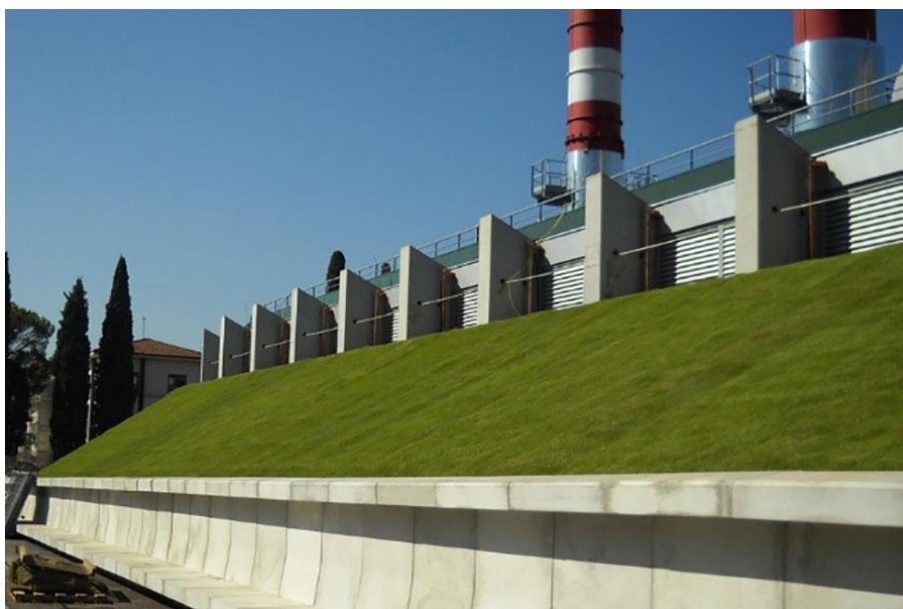
Figura 52 - Tetto verde estensivo nel Nuovo ospedale Careggi (FI)
