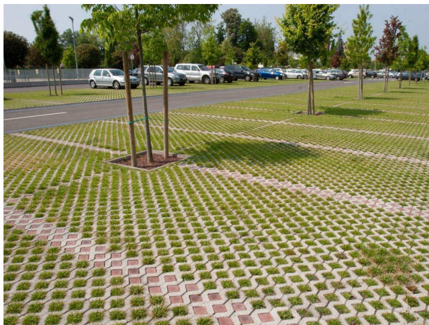
Figura 48 - Pavimento drenante per parcheggio
