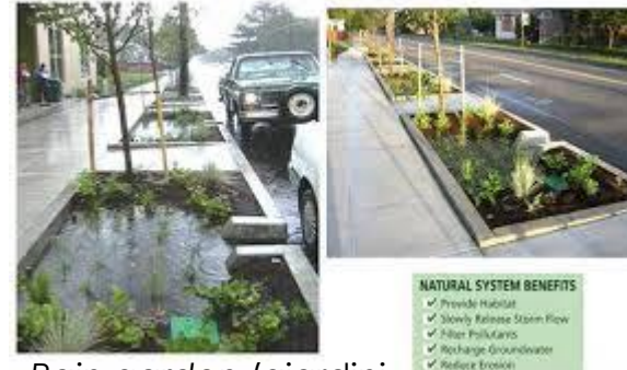
Rain garden (giardini della pioggia)
