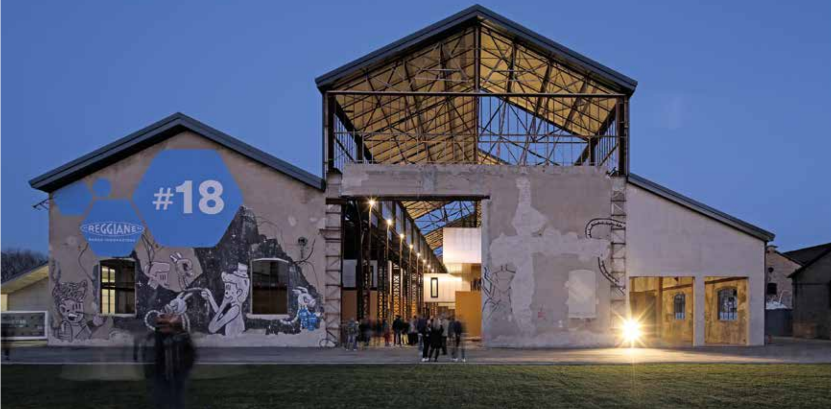
Riqualificazione del Capannone 18 nell'area ex "Officine Reggiane", Reggio Emilia, 2019, arch. Andrea Oliva (foto Kai-Uwe Schulte Bunert)
