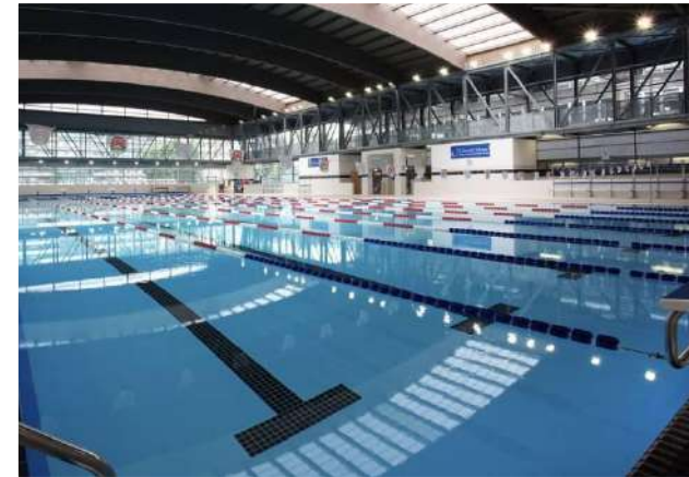
TERZIARIO: IMPIANTISTICA ED EFFICIENZA
