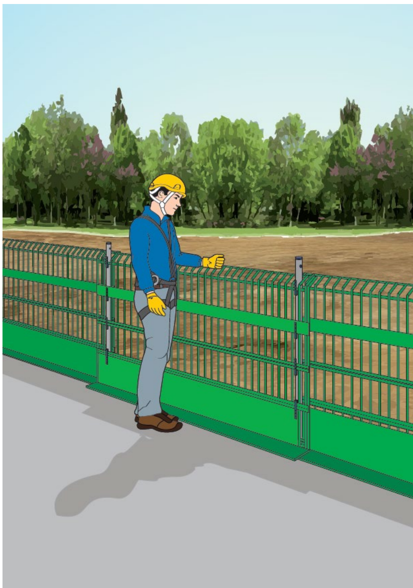
Figura 2 - Parapetto anticaduta provvisorio costituito da un pannello
