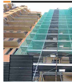
▲ Il superbonus Un cantiere a Milano
