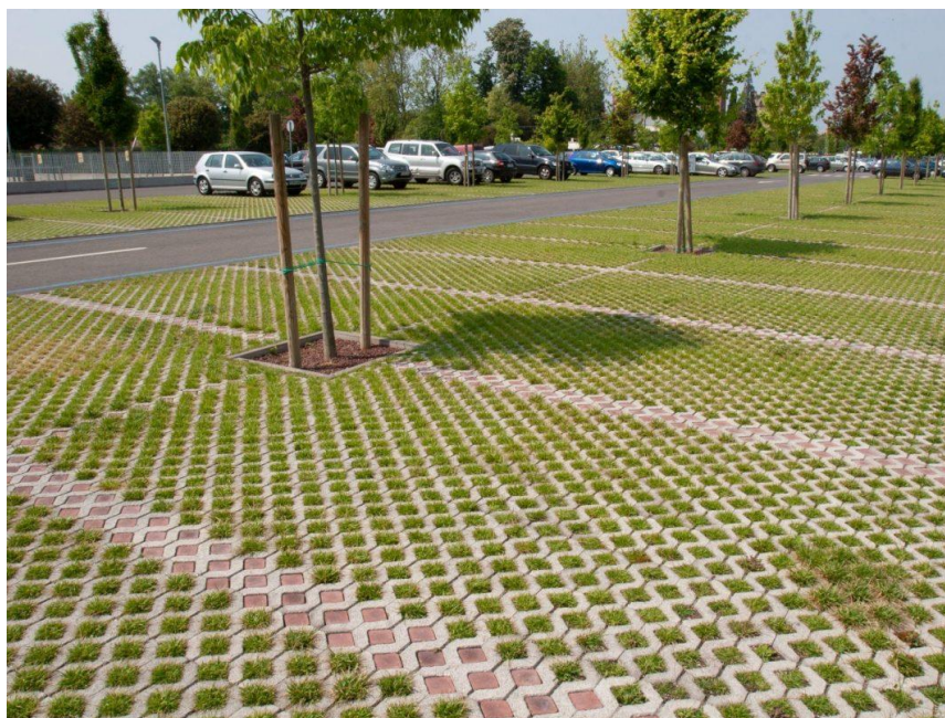
Figura 48 - Pavimento drenante per parcheggio
