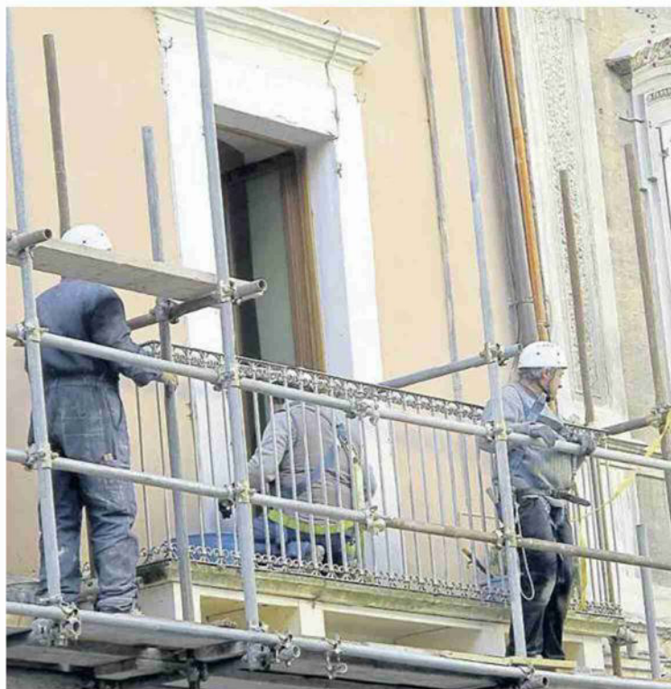
I lavori di ristrutturazione di un edificio
