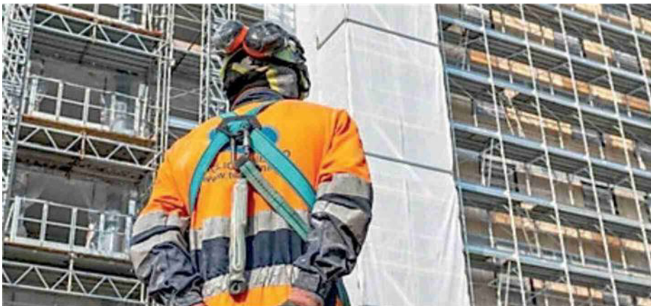
Un operaio di un cantiere edile ANSA
