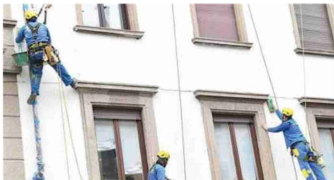
Operai al lavoro per ristrutturare la facciata di un palazzo: numerosi gli interventi grazie al superbonus
