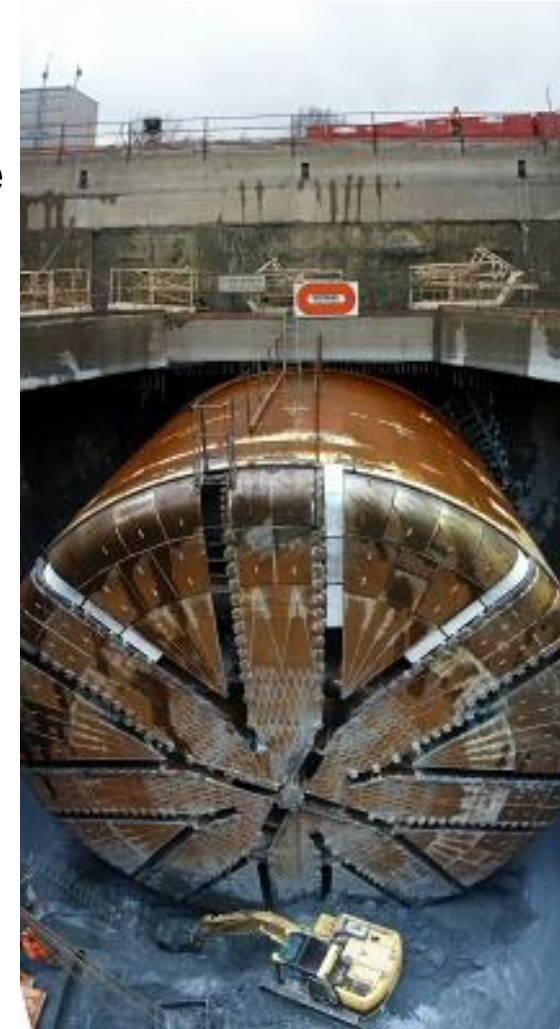
Robot per tunnel
