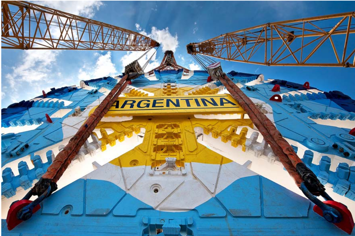
Ghella Linea Ferroviaria Sarmiento – Argentina 2011
