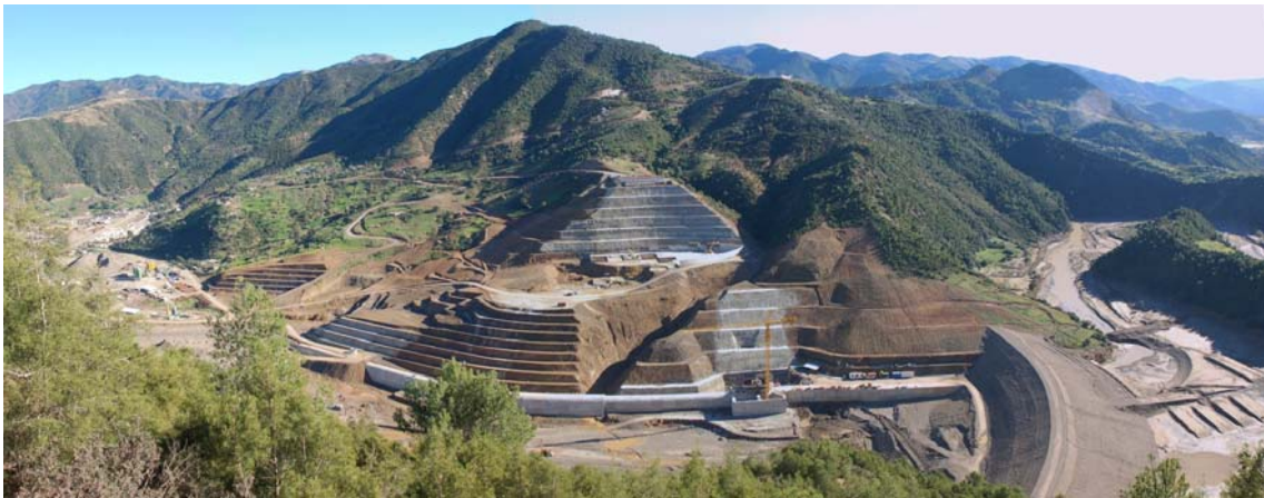
Pizzarotti - Diga di Kef Eddir Wilaya - Algeria
