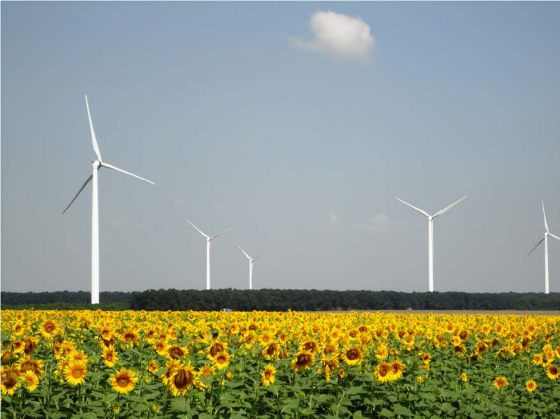
Ferretti International - costruzione pale eoliche - Kavarna (Bulgaria)
