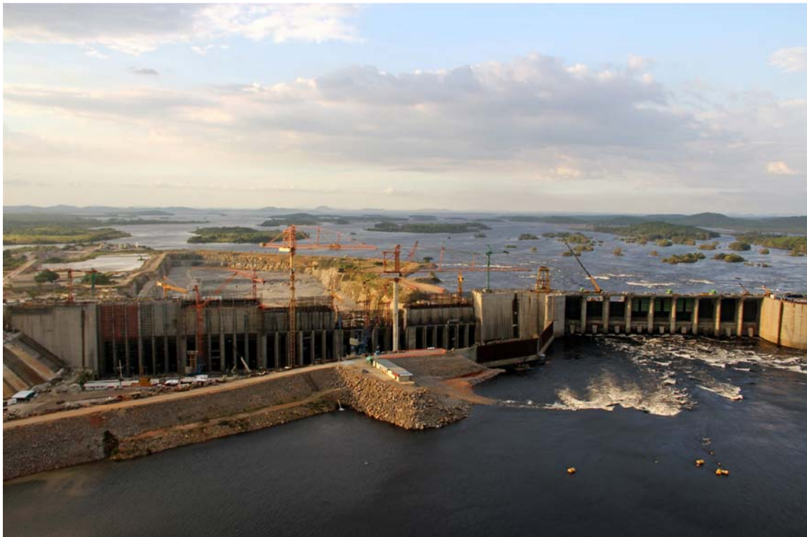
Impregilo - Impianto idroelettrico di Tocomá – Venezuela
