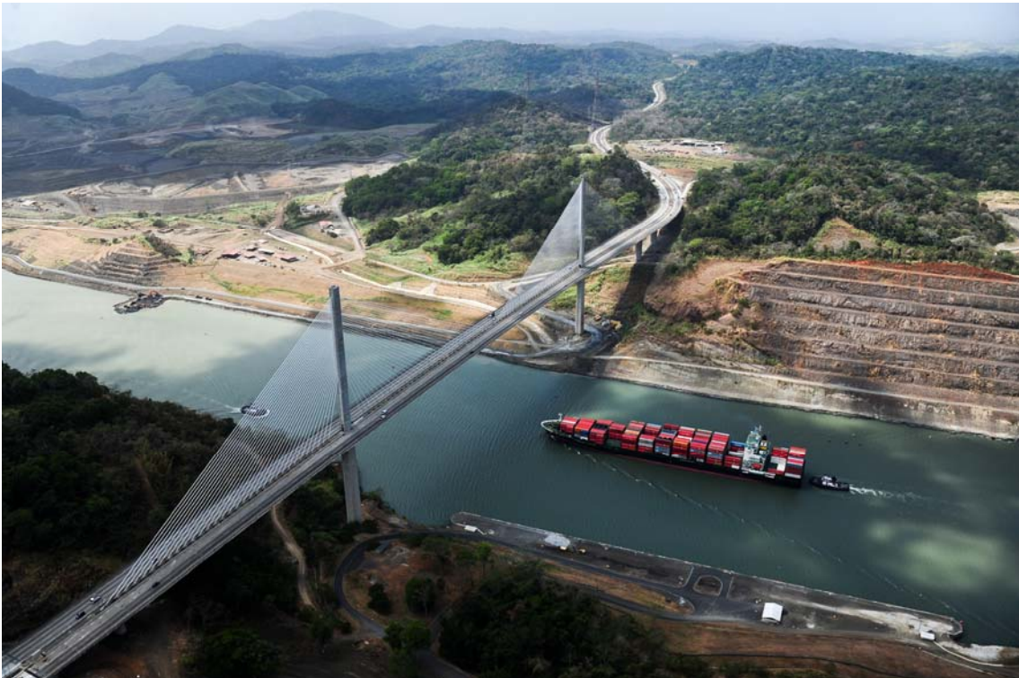
Impregilo - Ampliamento del Canale di Panama, terzo set di chiuse
